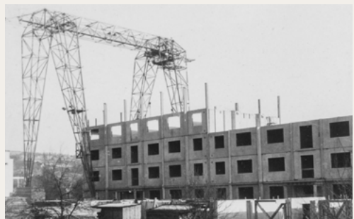
Stavba prvního paneláku v ČR, s novým typem jeřábu – Zlín
